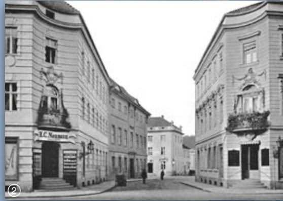
Schwertfegerstraße 9 Wohnhaus 1771 Georg Christian Unger Bestandteil des Ensembles „Acht Ecken“
