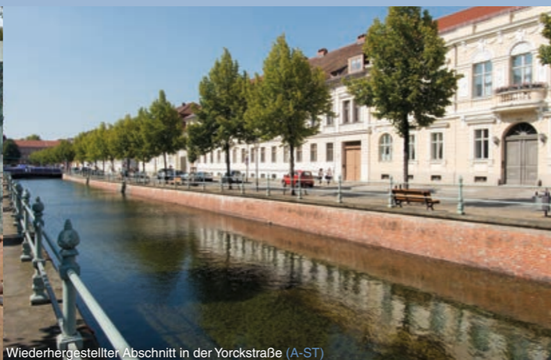
Wiederhergestellter Abschnitt in der Yorckstraße (A-ST)
