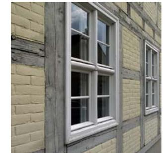
**zu (2) |** Traditionell werden die Fenster bei Mauerwerksbauten zwischen 0,10 und 0,15 m zurückgesetzt, mit einem sogenannten Anschlag, eingebaut.
