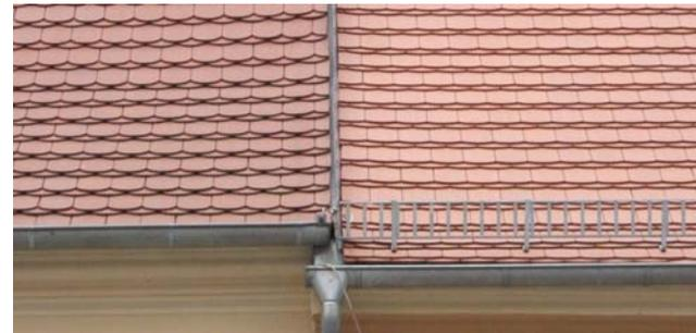
**zu (4) |** Die bautechnische Trennung aneinandergrenzender Dachflächen durch einen Stehfalz aus Zinkblech dient auch zur klaren visuellen Trennung benachbarter Gebäude im Dachbereich. Damit wird der Einzelhauscharakter der Gebäude unterstützt.
