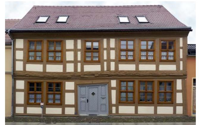
**(9)** Bei Fachwerkgebäuden darf die Fachwerkkonstruktion in ihrer statischen Funktion und Anordnung nicht verändert werden. Fehlende oder nicht mehr tragfähige Teile sind originalgetreu in handwerklich ausgeführter Holzkonstruktion zu ersetzen.
