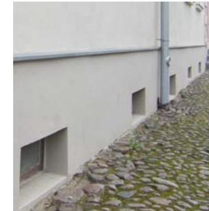
**zu (11)** | Die Ausführung von Gebäudesockeln ist für die Gebäude in Neuruppin ein typisches architektonisches Merkmal. Der nachträgliche Schutz der Sockelkante mit Zinkblech ist zulässig, aber nicht gefordert.
